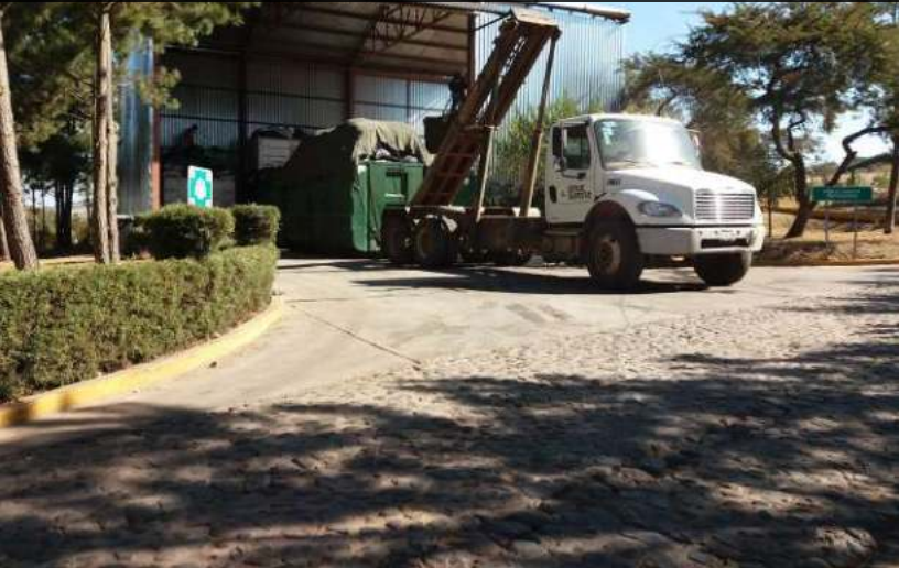
Vista de la estación de transferencia intermunicipal SIMAR Sureste, 2018
