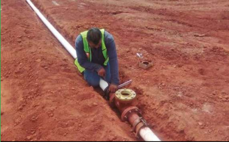
Instalación del sistema de recirculación de lixiviados para celda II del relleno sanitario intermunicipal.
