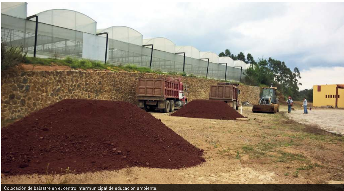
Colocación de balastre en el centro intermunicipal de educación ambiente.
