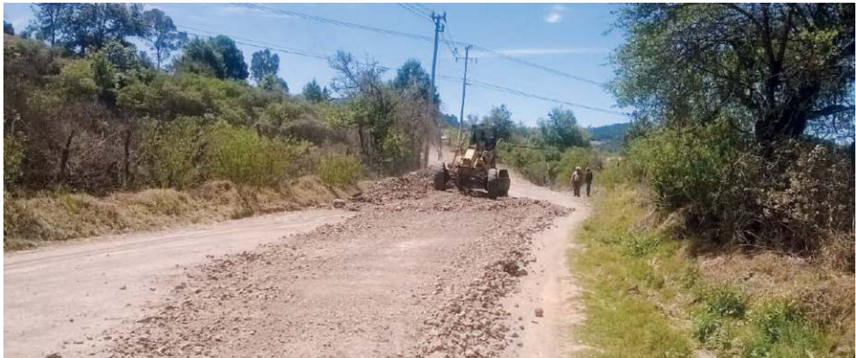
Trabajos de mantenimiento del camino de acceso al relleno sanitario intermunicipal previo al temporal de lluvias 2016.
