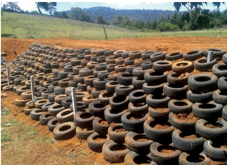
Aprovechamiento de neumáticos para taludes, Mazamitla 2015
