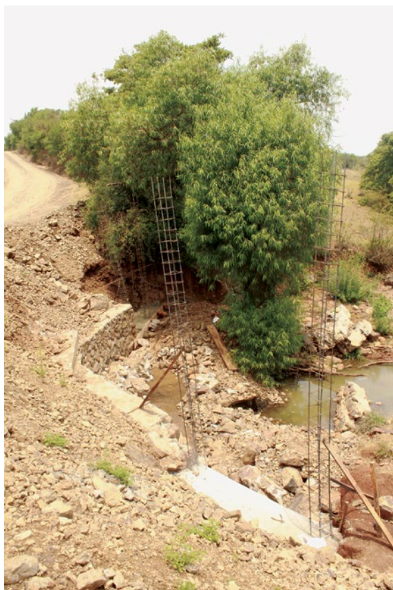
Construcción de puente de acceso al relleno sanitario intermunicipal. Abril 2015
