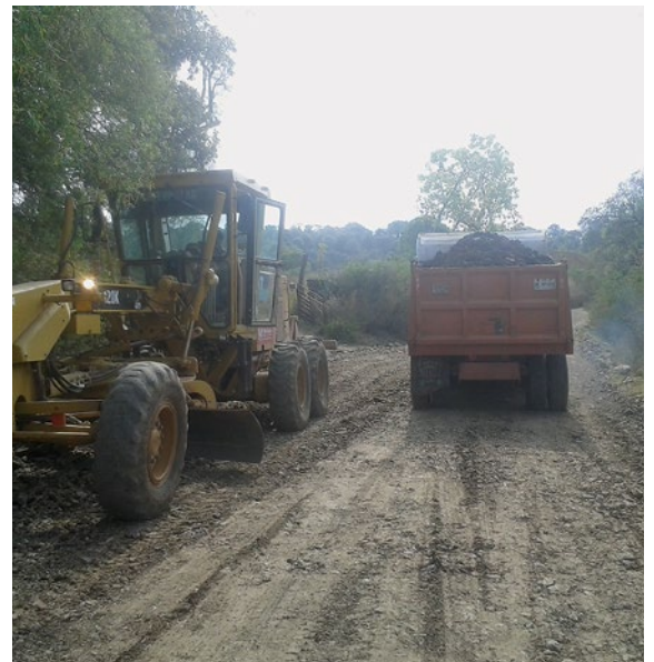
Mantenimiento de brecha camino al relleno sanitario intermunicipal de SIMAR Sureste , 2015
