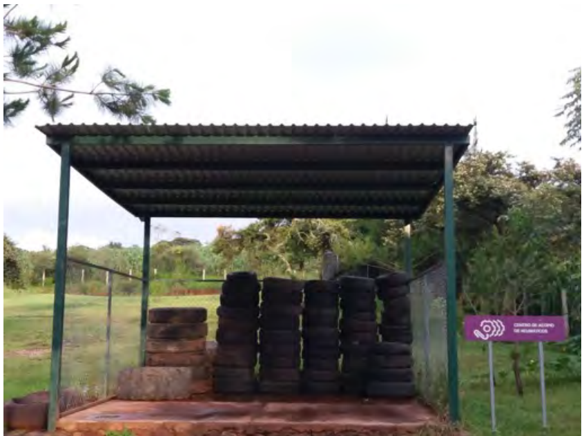
Área de almacenamiento de neumáticos usados
