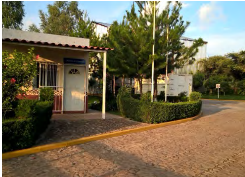
Ingreso a las instalaciones de transferencia de residuos sólidos
